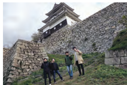
丸亀城での石垣健全性調査の実施
