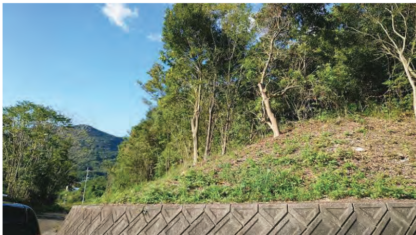
高速道路沿いの法面の様子
